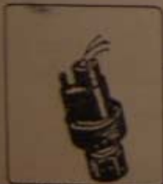
PRESSOSTATO DE BAIXA PRESSÃO PRESSOSTATO MOTRÔNICO NA TUBULAÇÃO ENTRE CONDENSADOR E EVAPORADOR
